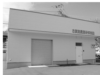
志賀島農業研修施設
